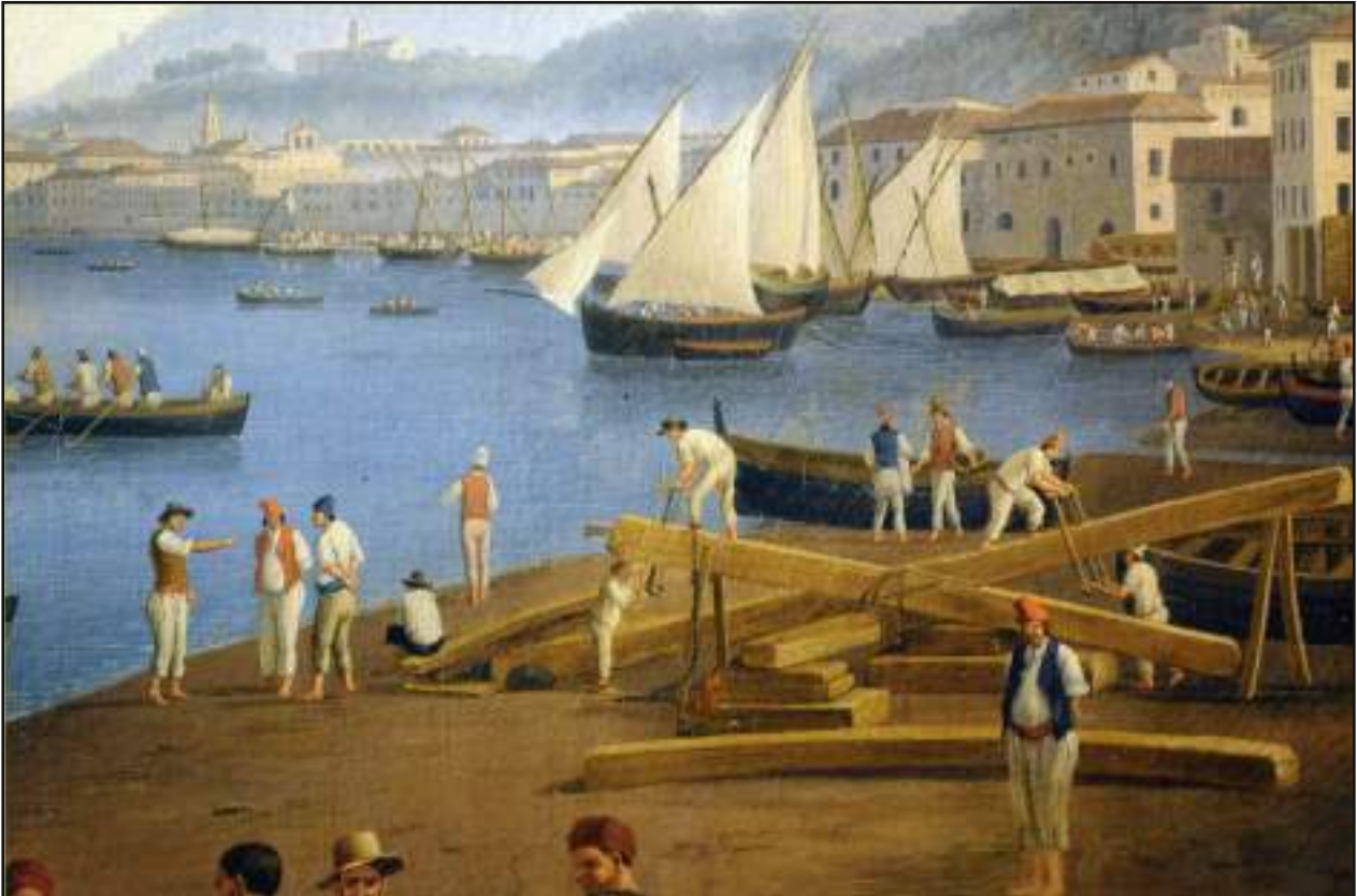
Castellammare di Stabia, particolare del taglio delle travi destinate alla costruzione dei vascell. (1789, Caserta, Palazzo Reale)
